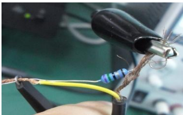
图 327 上电运行测试图片 Fig327 operation test
